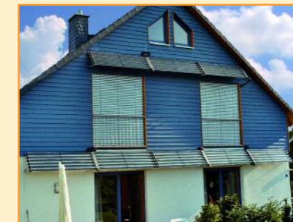
Angestellte Fassadenmontage von 8 TUBO-Modulen, Deutschland
