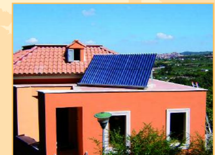
Aufgeständerte Lösung von 6 TUBO-Modulen, Italien
